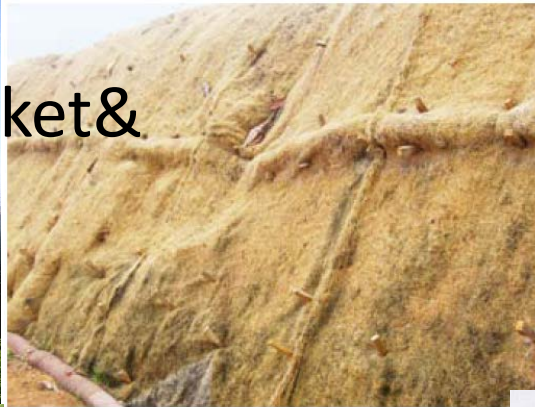
การทดลองใช้ผ้าห่มดินและหมอนกันดิน
